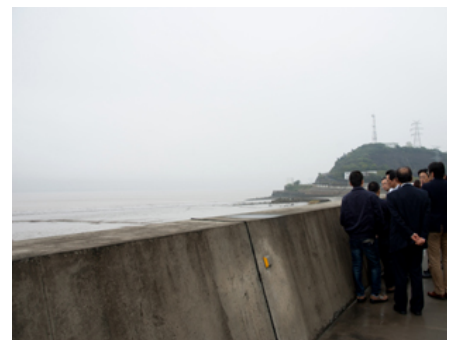
秦山原子力発電所 防潮壁
